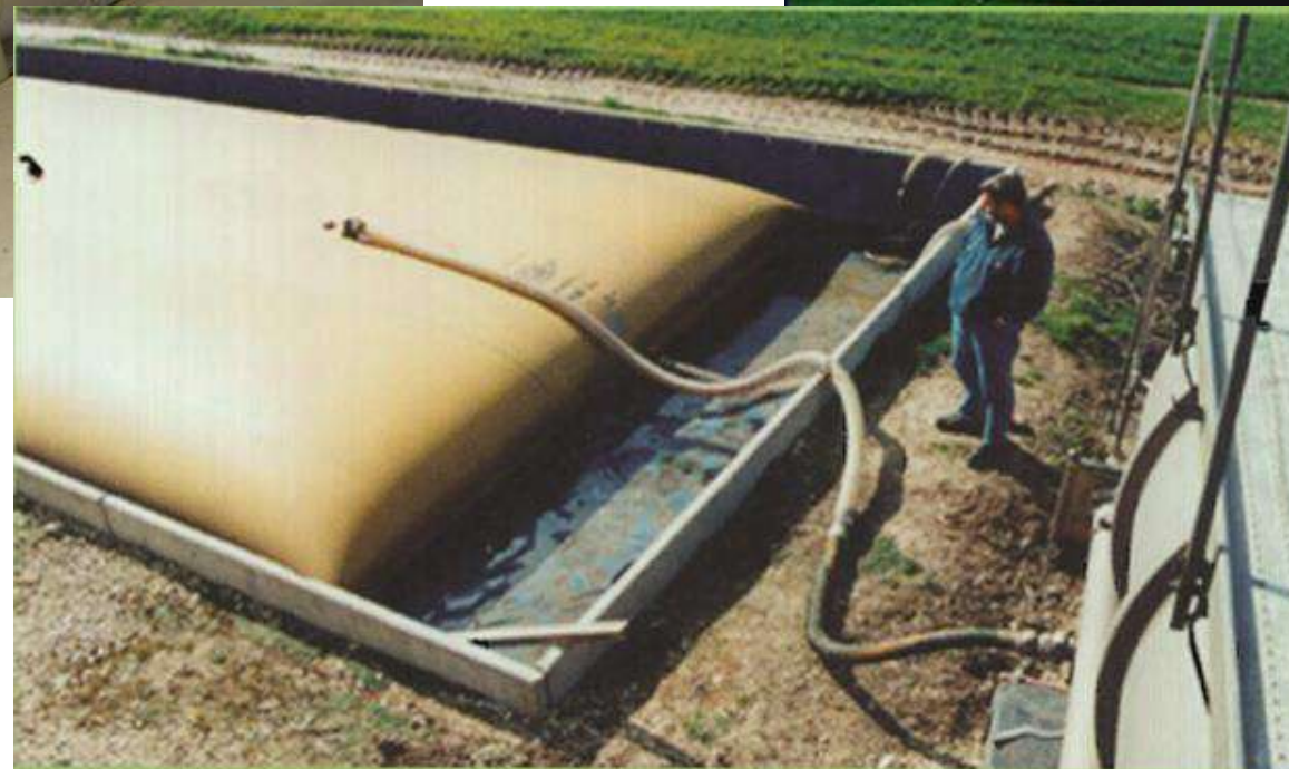
99 m 3 -Tank beim Einfüllen
